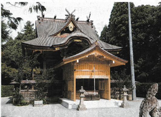
改修作業が終了した奥宮本殿
